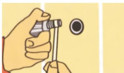
Резьбу нового углового вентиля смазать герметиком и обмотать пенькой. Как альтернативу можно использовать тефлоновую ленту. В итоге цилиндрический конец должен указывать вверх.
