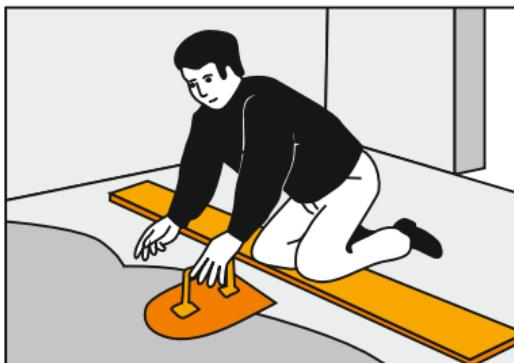
Время саморазглаживания – приблизительно 15 мин. Неровности исчезают по мере высыхания смеси. Время сушки (от 2 до 4 часов) определяется толщиной покрытия и температурой помещения. Если Вы хотите нанести второй слой, предварительно нанесите первичную грунтошпаклевку для усиления схватывания первого слоя. Подождите 24 часа, прежде чем делать новое покрытие или второй слой.
