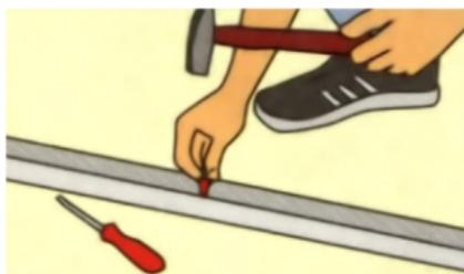
Отрезать по размеру горизонтальный профиль (ПН-профиль) и закрепить на полу и на потолке специальными забивными дюбелями (расстояние между дюбелями около 50 см).
